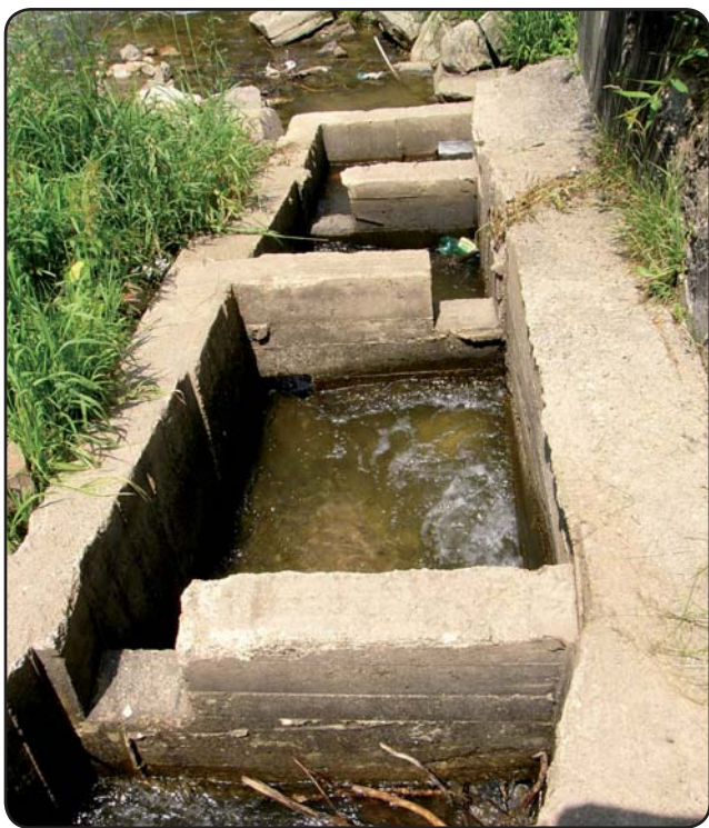
Obr. 6: Nefunkčný komôrkový rybochod MVE Bujakovo
