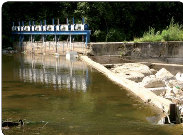
Obr. 5: Odber vody na derivačnú MVE v Bujakove na Hrone
