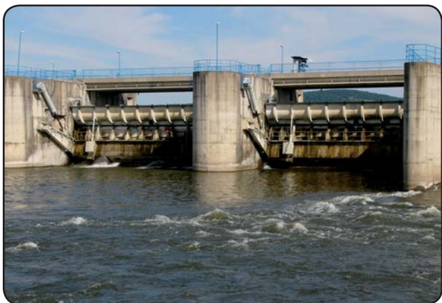
Obr. 4: Vysoká klapková hať MVE Veľké Kozmálovce na strednom Hrone
