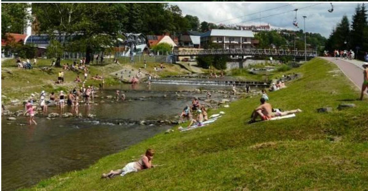
Obr.15 a 16: Príklady využívania kosených plôch bermy na oddych, tienisté oddychové miesta pod stromami, sadenými nad povodňovou hladinou, estetické výsadby hornej časti svahu hráze, využívanie plynulého prechodu trávneho brehu do štrkových lavíc a plytčín koryta na ovlažovanie a hry vo vode, ponechanie sezónnych ostrovčekov v koryte.
