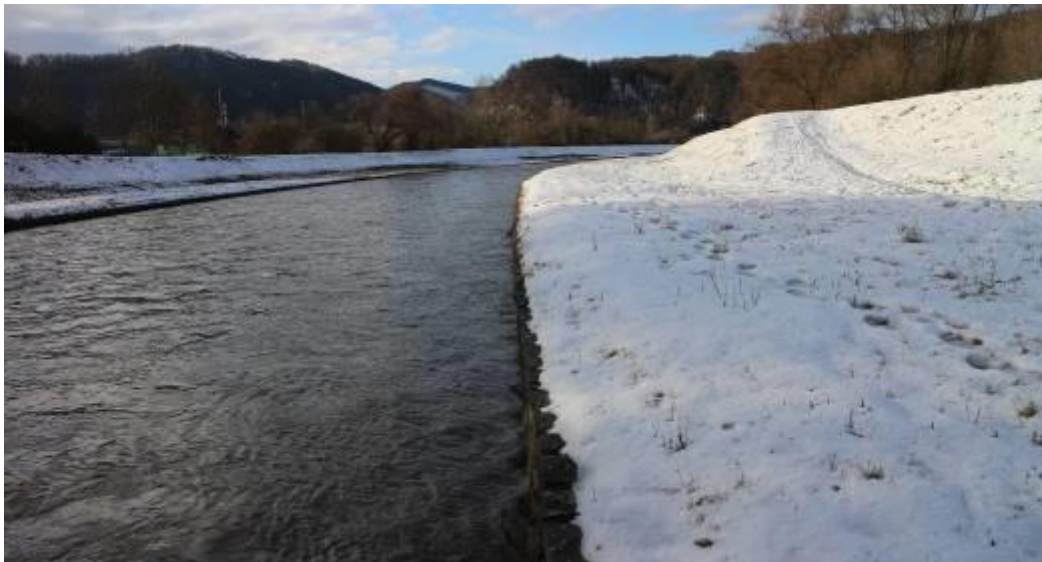
Obr.11 Úsek brehu poniže mosta pri sídlisku Západ – odporúčané plynulé plážové úpravy brehu rieky
