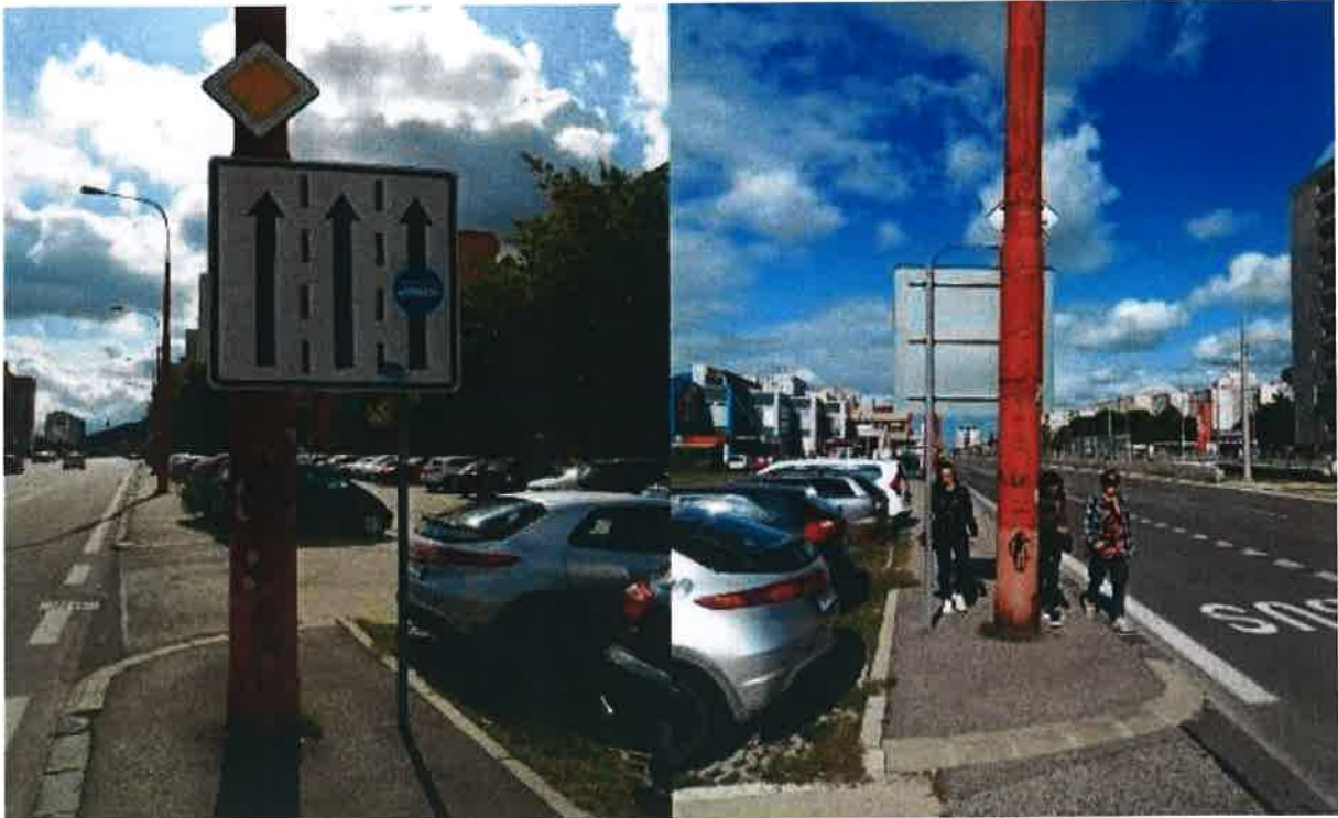
Obrázok 12-2 Nevhodne umiestnený stĺp verejného osvetlenia a nosič dopravnej značky (Zdroj: Spracovateľ)
