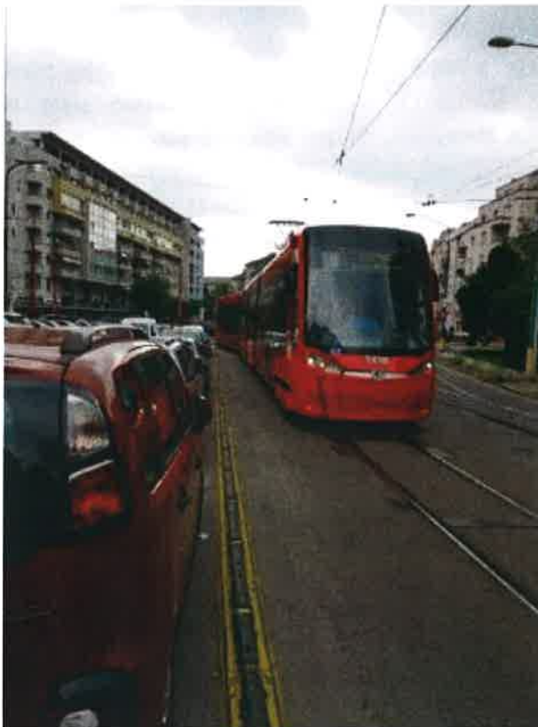
Obrázok 5-1 Ochrana električkového telesa vodiacim prahom (Zdroj: Spracovateľ)
