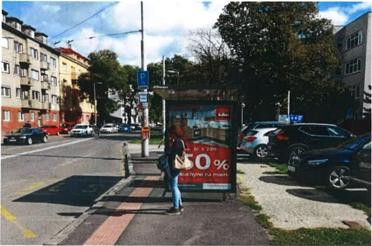
Obrázok 12-3 Nevhodne umiestnený prístrešok na zastávke MHD. Pritom je priestor na jeho umiestnenie za hranou chodníka. Zároveň je aj nevhodné prevedenie prístrešku s nepriehľadnou bočnou stenou vyplnenou reklamou na strane príjazdu vozidla MHD (Zdroj: Spracovateľ)
