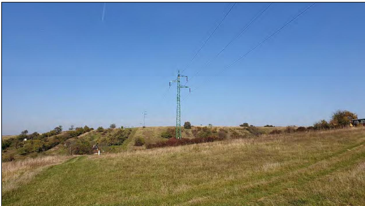
Foto 2: Severozápadný pohľad na dotknuté územie, v zábere 110 kV elektrické vedenie
