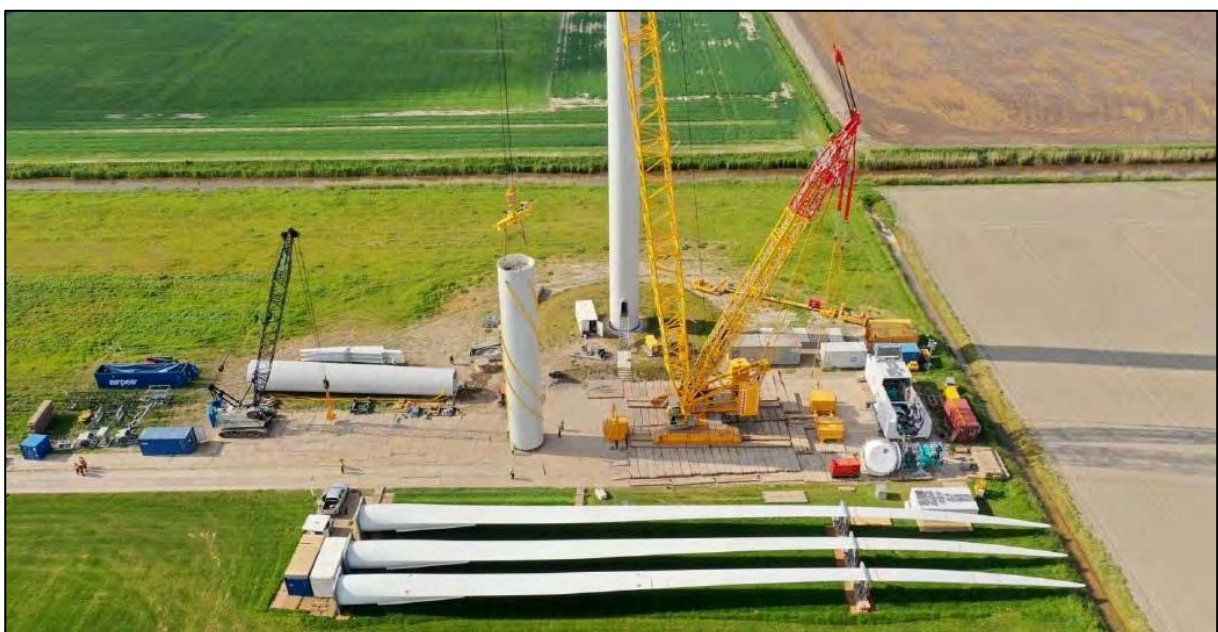
Obrázok 5: Postup pri výstavbe veternej elektrárne
