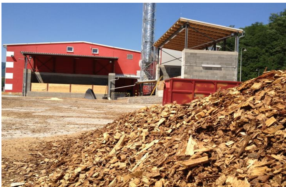
Obrázok 12 Kotolňa na biomasu na Železničnej ulici
