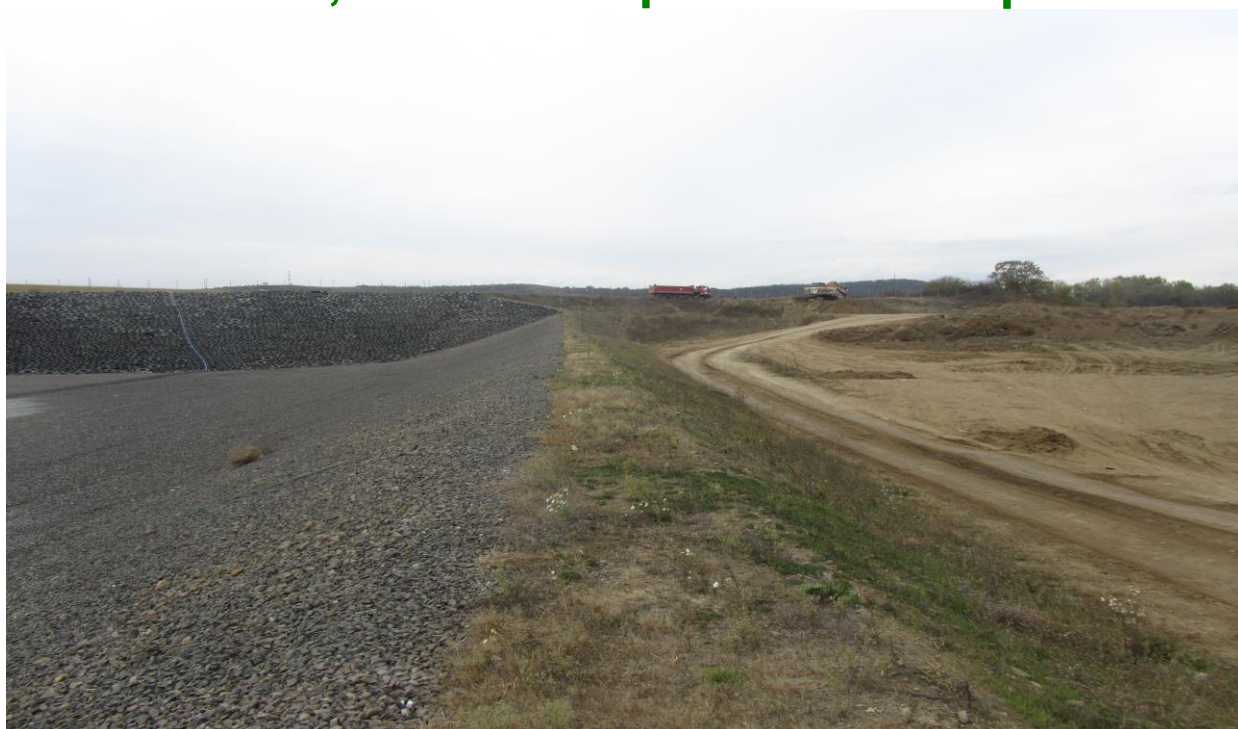
Obr. Napojenie IV. etapy na vybudovanú III. etapu skládky odpadov Sírnik.
