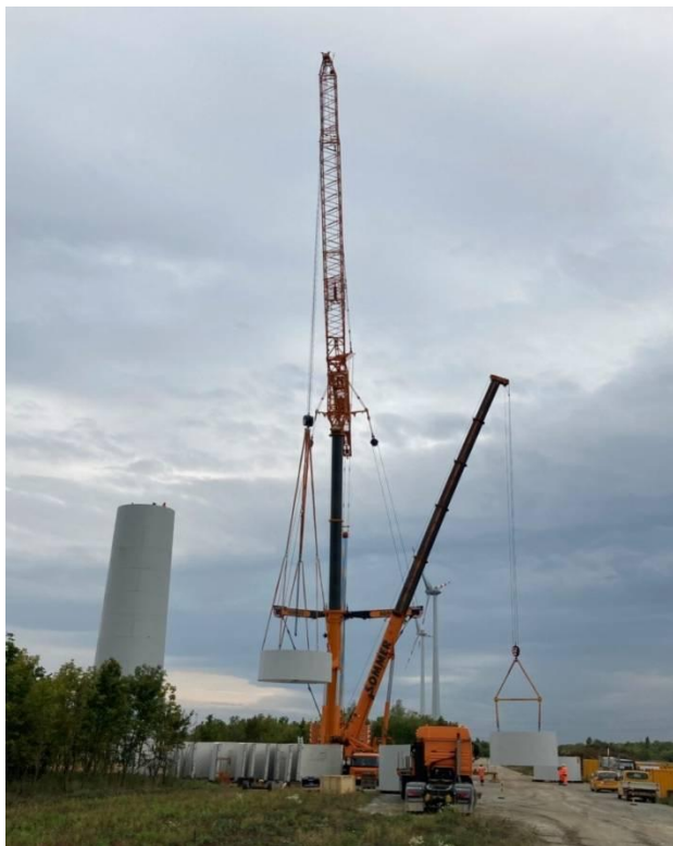
Obr. č. 4 Príklad výstavby veternej elektrárne s použitím žeriavu
